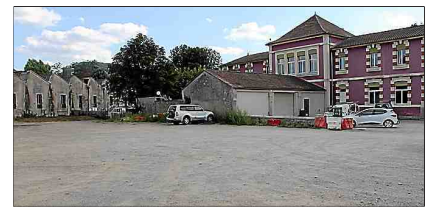
■ L'aire de la rue du Mazet en chantier pour deux mois.
